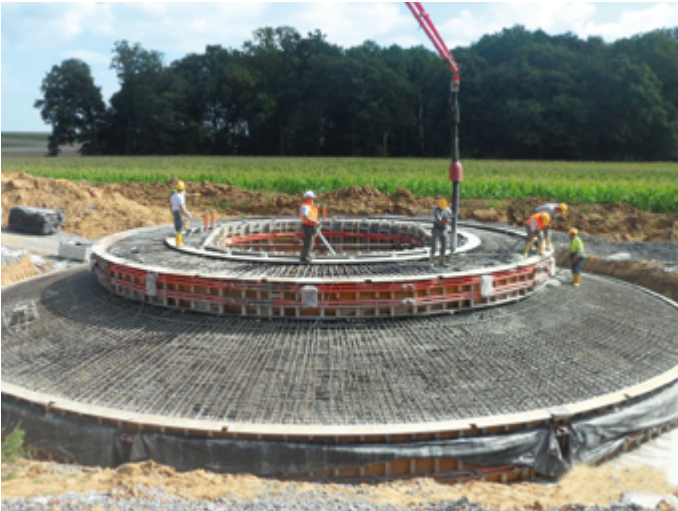
Das Fundament einer Anlage wird betoniert.
