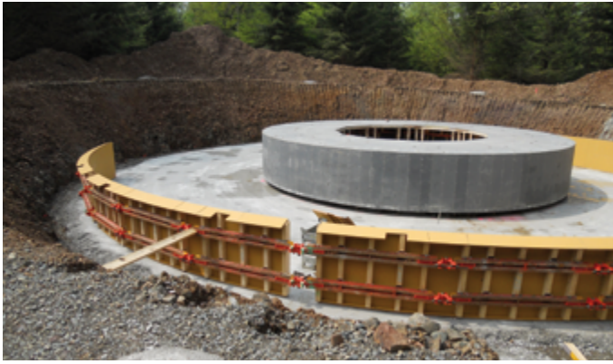
Auf einer Grundfläche von 400 Quadratmetern entsteht das Fundament der Windkraftanlage. Der Durchmesser beträgt 22,5 Meter.
