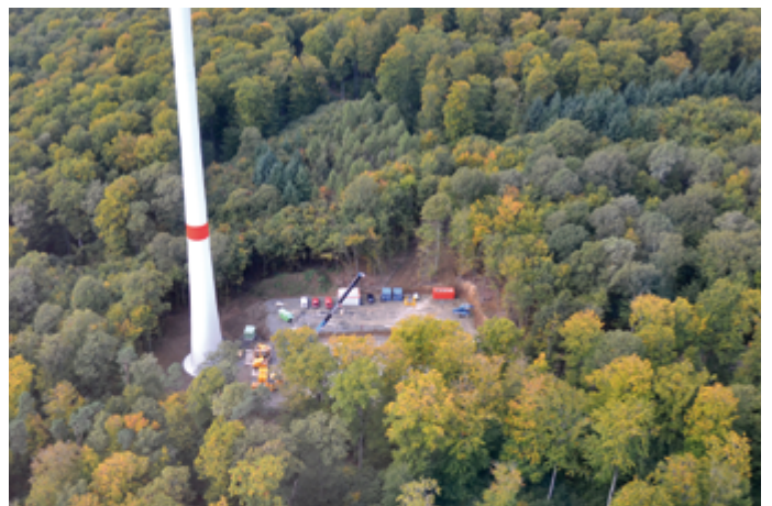
Der Blick aus 140 Metern Höhe auf den Kranstellplatz vor dem Turm der Anlage.
