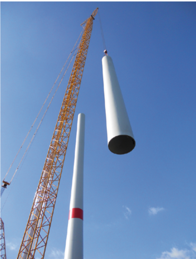
... auf die anschließend Stahlrohrsegmente gesetzt werden.
