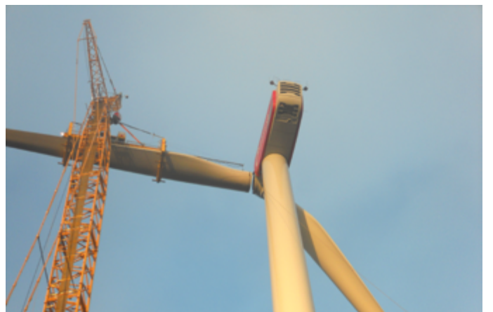
An der Spitze des Turms wird die Gondel montiert. Die Rotorblätter werden angeliefert und nacheinander an der Nabe befestigt.
