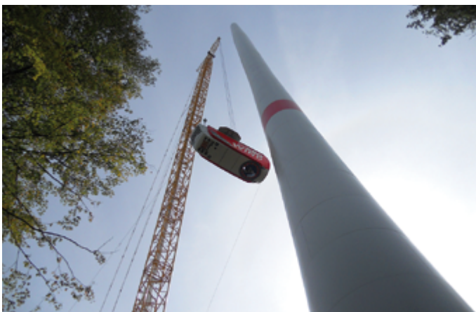
Langsam zieht der Kran die Gondel nach oben.
