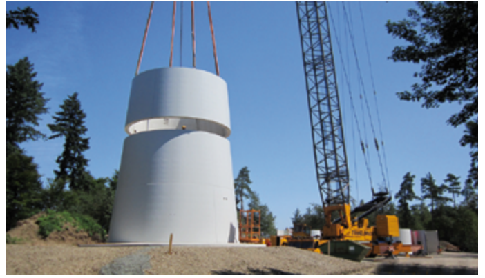
Der untere Teil des Turms besteht aus Betonsegmenten...
