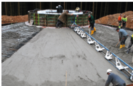
Ein Fundament wird gegossen.
