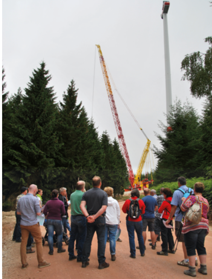
Viele Bürger verfolgten die Bauarbeiten mit Interesse.
