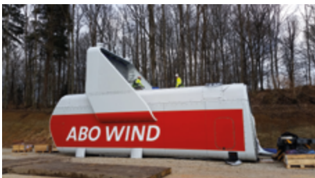
Die Montage des Maschinenhauses wird vorbereitet.
